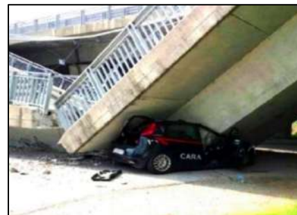
18/4/17_Svinc. tang. Fossano (CN) Collasso strutturale (cause incerte)
