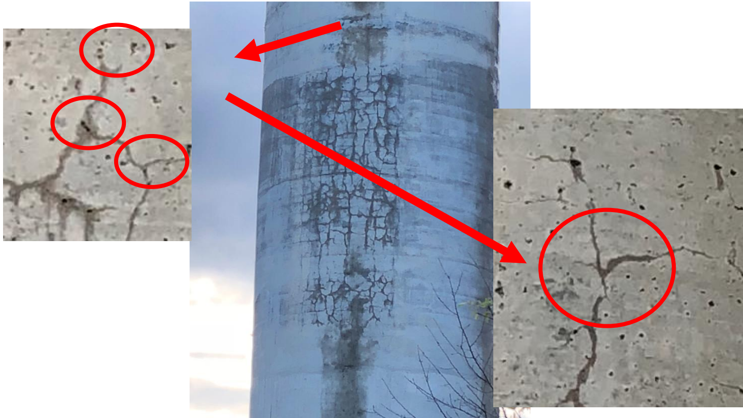
Pila di viadotto in Provincia di Macerata.
