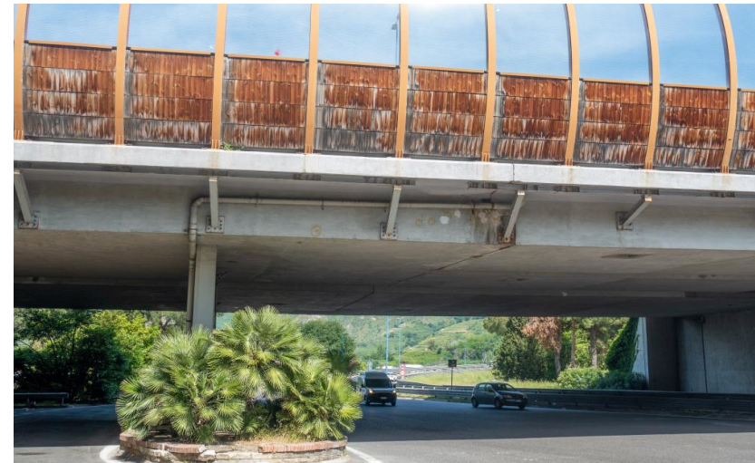
installazioni tipo delle barriere fonoassorbenti, sugli scatolari (sx) e sulle travi (dx)
