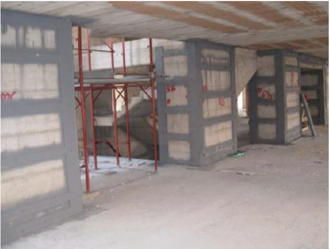
Fig.7 – Incamiciatura di pilastri in acciaio durante il cantiere
